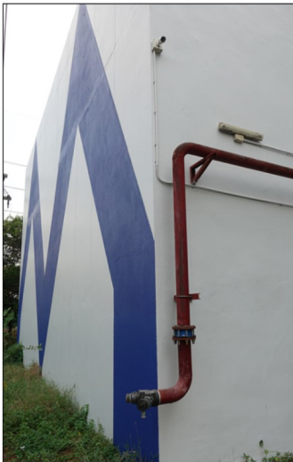
หัวรับน้ำดับเพลิง ที่ตั้ง: ด้านหลังของสระว่ายน้ำ
