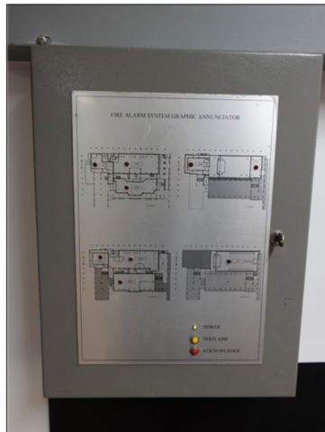
ตู้แสดงสัญญาณระบบแจ้งเหตุเพลิงไหม้ ที่ตั้ง: ห้องสำนักศูนย์วิทยบริการ อาคารศูนย์วิทยบริการ ชั้น 1
